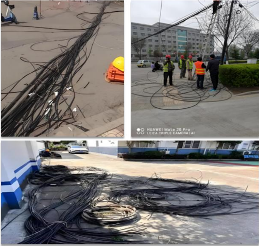
违规暴力剪线，导致大面积网络中断故障
