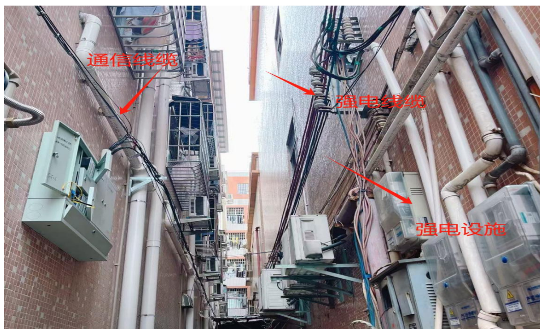
通信与强电线路分道路两侧架设
